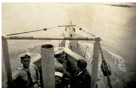
Fotografía poco usual tomada desde la vela de un R . Esta unidad se encontraba navegando rumbo a Belén. Archivo Histórico de Marina.
