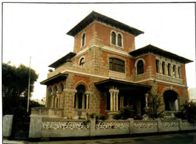
Residencia de tres pisos de ladrillo y lajas, como rezago de los buenos viejos tiempos.
